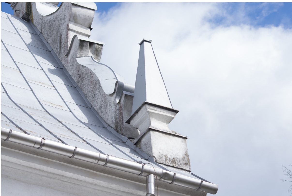
stan istniejący – obróbki blacharskie
