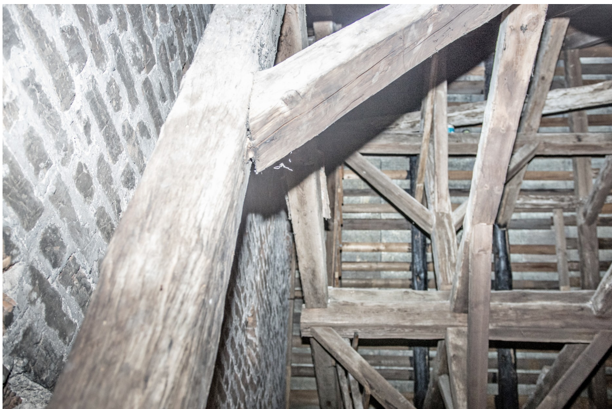
stan istniejący - więźba dachowa
