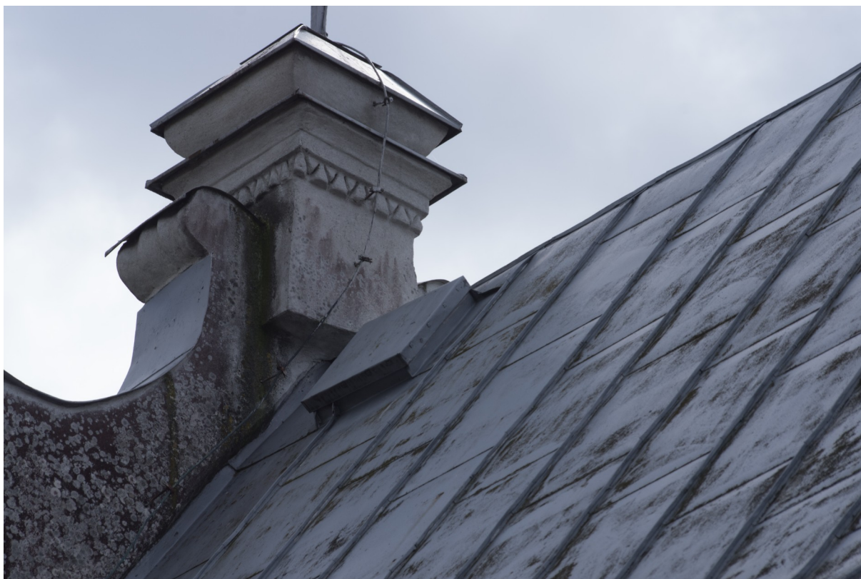
stan istniejący – wyłaz dachowych
